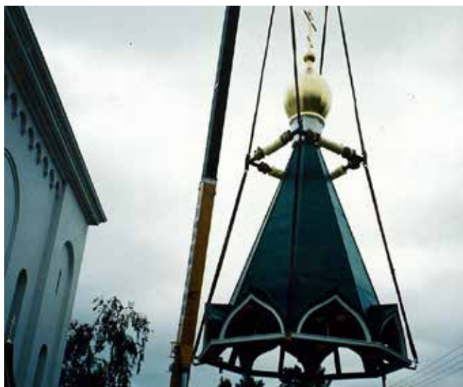
Подъёмный кран поднимает отреставрированный купол
